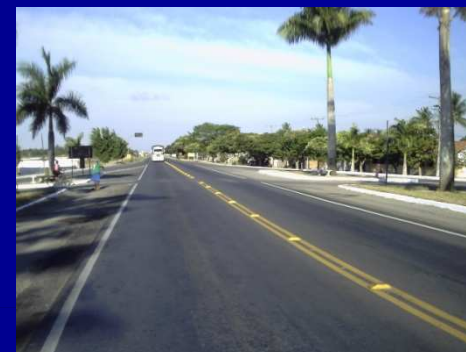
Pintura de faixas e tachas
